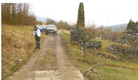
Prístupová cesta, pohľad severný
